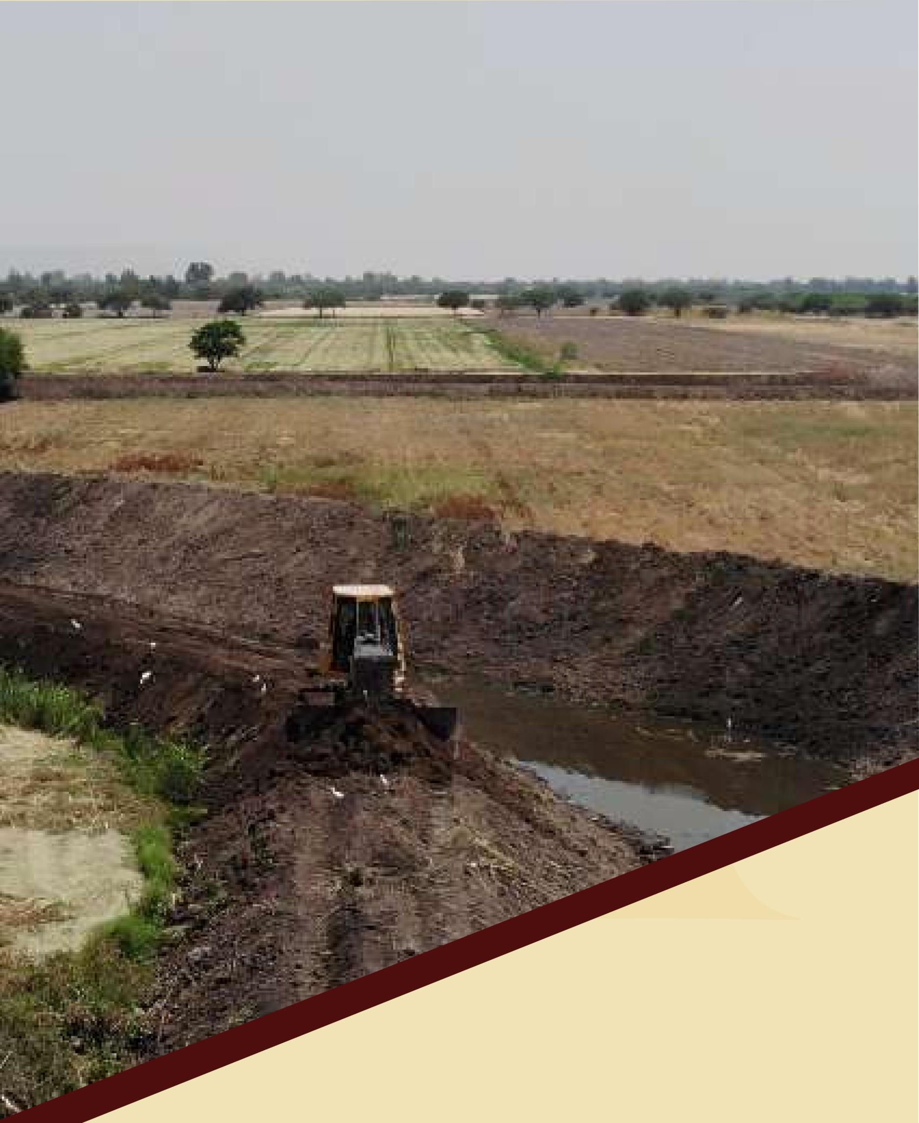
**Las acciones que se han realizado son: Limpieza, desazolve y reforzamiento de bordos en el tramo de “El Tecuán” al puente de la carretera a “San Juan de la Puerta”, donde se logró eliminar la estructura que obstruía el flujo del agua. El material producto del desazolve fue utilizado en el reforzamiento de bordos.**
